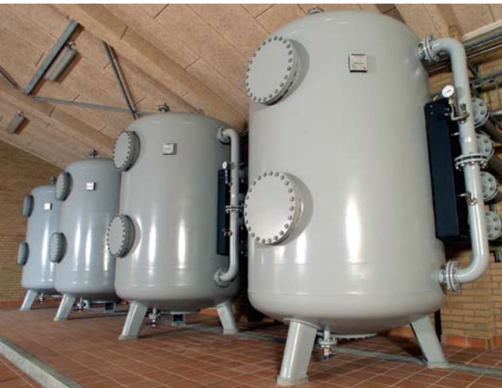
Vas, mangán és ammónia eltávolítás egy vízműben. Tömegáram: 2 x 35 m 3 /h.
