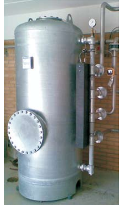
Arzén eltávolítás adszorpciós módszerrel egy vízműben. A rendszer áll egy nyitott szűrőt követő NSB170 nyomásszűrőből. Tömegárama: 12 m 3 /h.
